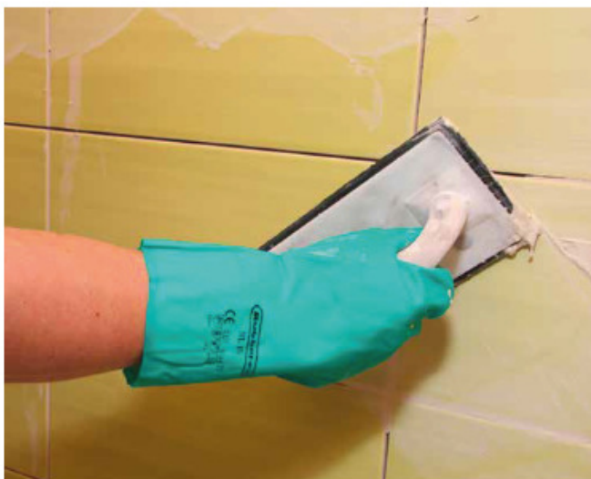
9 Spoinowanie ściennych płytek ceramicznych fugą Sopro DF 10®.
