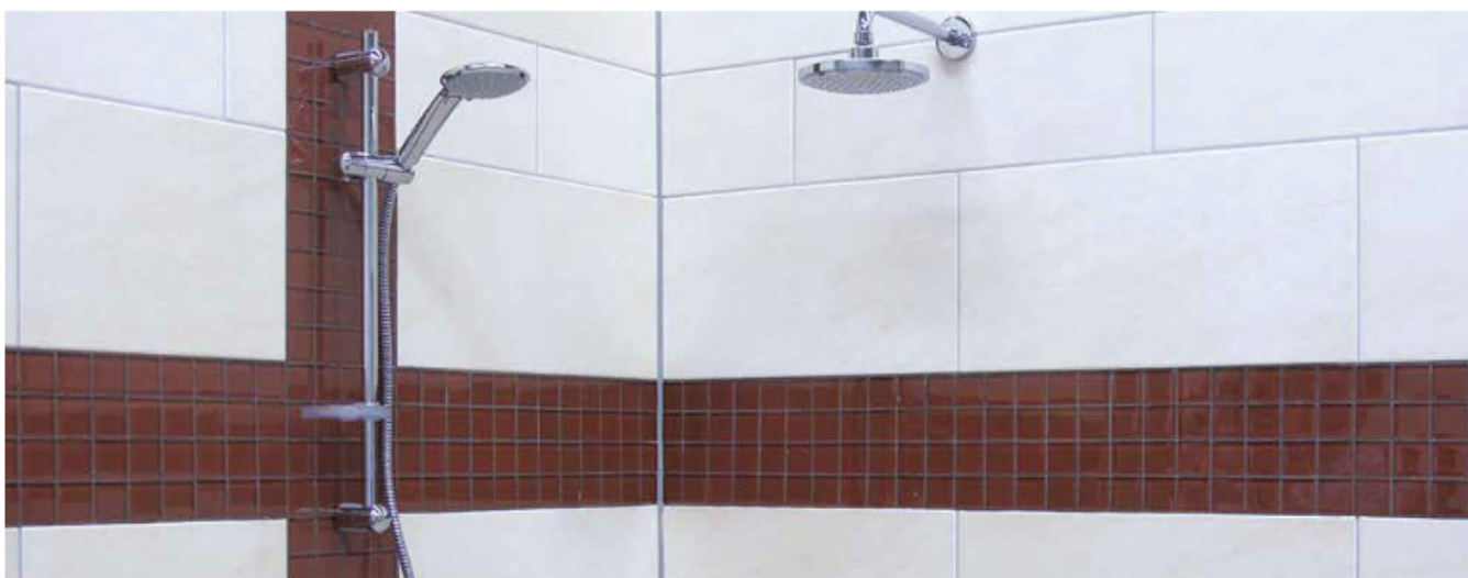
11 Okładzina w łazience zaspoinowana fugą Sopro DF 10®.
