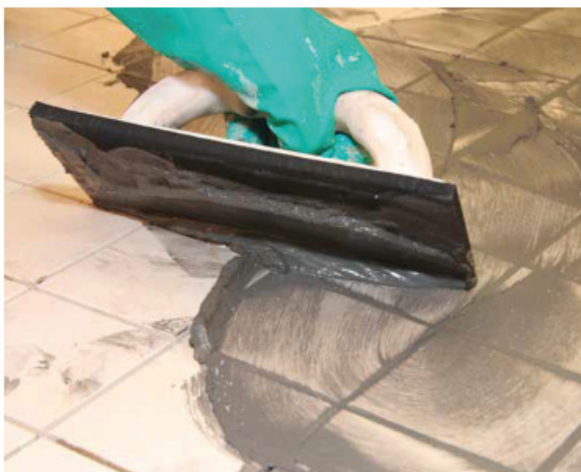
7 Spoinowanie płytek gresowych Design Fugą Flex Sopro DF 10®.
