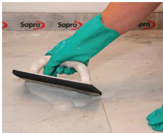
8 Spoinowanie wrażliwego na przebarwienia kamienia naturalnego fugą Sopro DF 10®.
